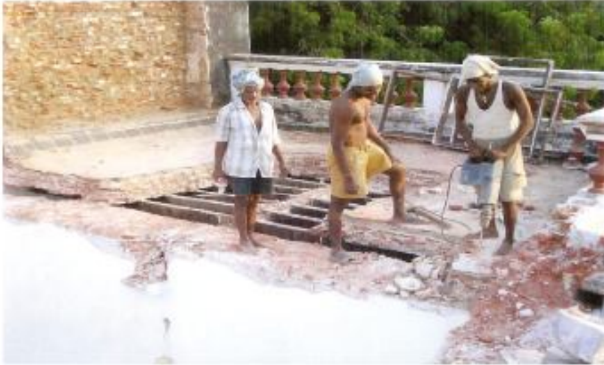
Demolition of the existing roof / Démolition du toit existant
