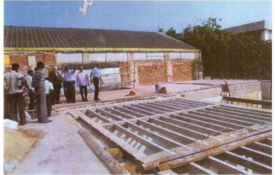
Seeing the "Madras" terrace roofing under progress Aperçu du toit terrasse 'Madras' en cours de construction
