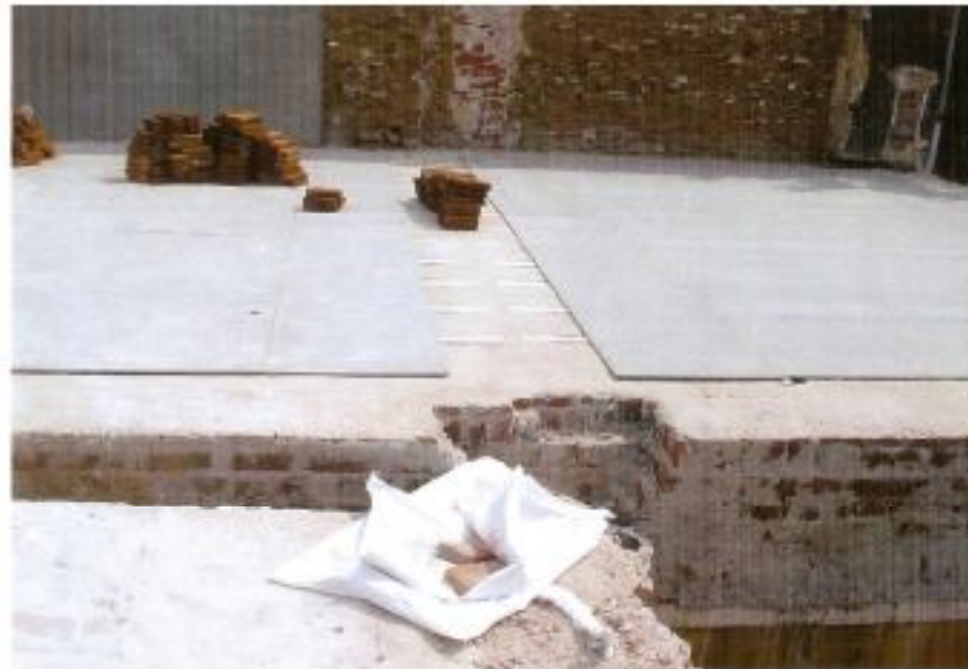
Bison board spread on the wooden joist / Mise en place du ciment 'Bison' entre les joints en bois (Workability is made easy) / (Réalisation simplifiée)
