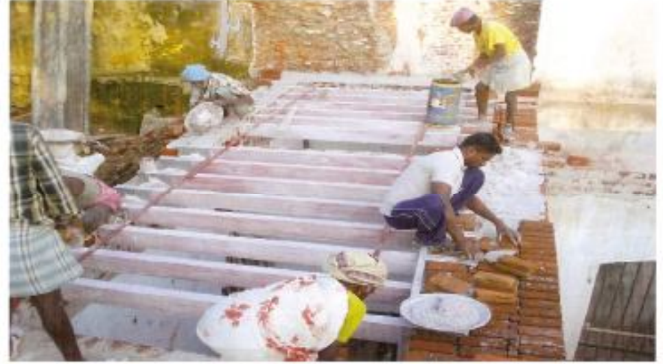
Levelling of the wall for laying of Madras terrace roof Aplanissement du mur pour la pose du toit terrasse 'Madras'
